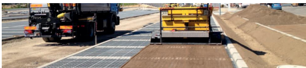
Obrázok 3 Pokladanie výplňového substrátu
