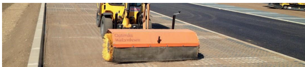
Obrázok 4 Vmetávanie výplňového substrátu do medzier
