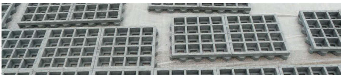
Obrázok 1 Pokládka TTE elementov na jemnú tkaninu (separačná sieťovina)
