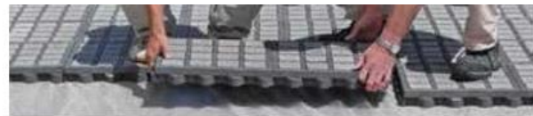
Pokládka zaplnených AS-TTE prvkov po dvojiciach
