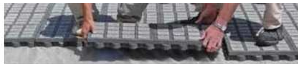
Pokládka zaplněných AS-TTE prvků po dvojicích
